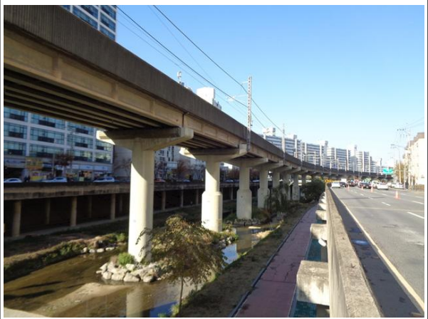
PSC구간 측면 전경
