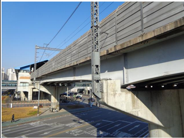
SPG구간 측면 전경
